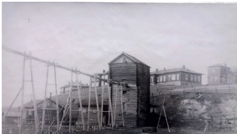
Рис. 2. Водоподъемная башня над скважиной Октябрьская. На заднем плане видны здания курорта «Серегово». На переднем плане – на высоких сваях находились рассолопроводы, по которым самотеком рассол поступал к варницам солевого завода. Фото из архива санатория «Серегово» (примерно 1930 г.)
