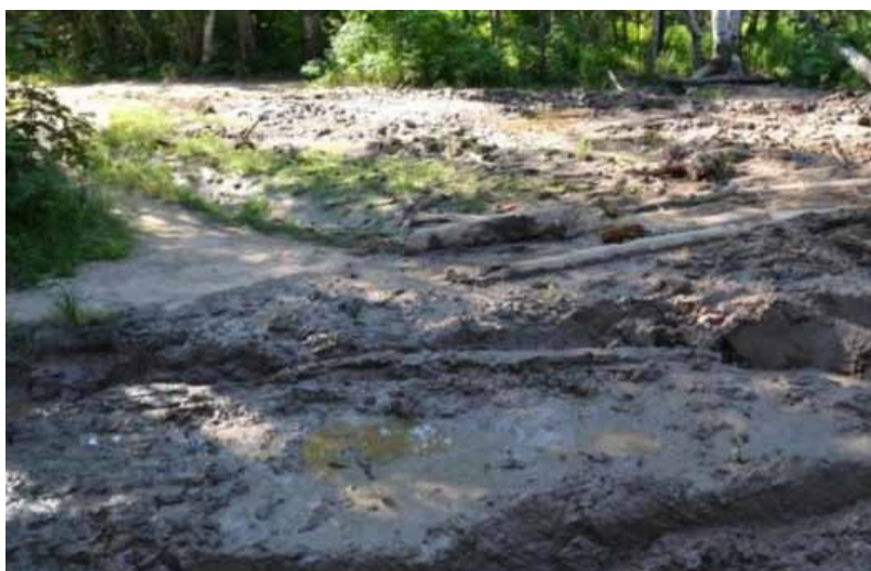
Рис. 1. Состояние лесной дороги до прокладки тротуара [3]
