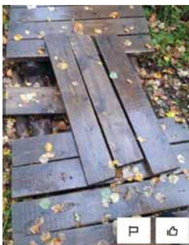
Рис. 3. Состояние разрушающегося настила [2]
