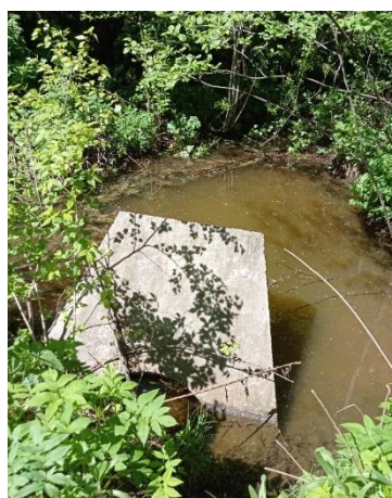
б) разрушенный порталный оголовок б) collapsed portal casing
