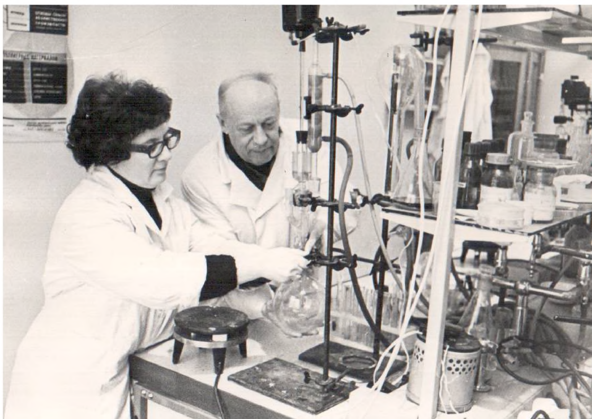
И.С. Бердинский и Л.Д. Орлова собирают установку для проведения магнийорганического синтеза
