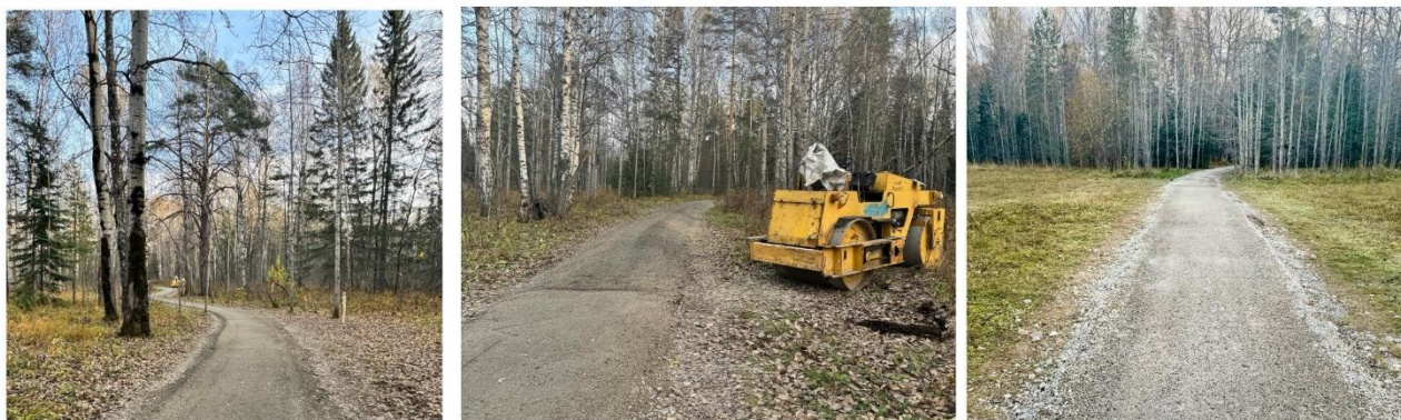
Рис. 2. Пешеходные тропы с щебневой отсыпкой Fig. 2. Pedestrian paths with crushed stone backfill [5]
