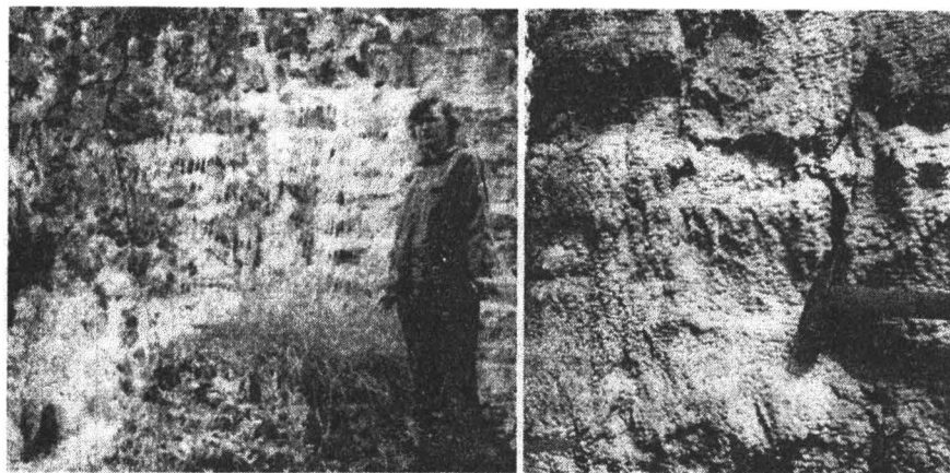
Рис. 4. Кальцитовые покровы (коры) на теле плотины на р. Б. Сатка (Челябинская область): а – общий вид, б – фрагмент сплошной коры на боковой стене плотины
