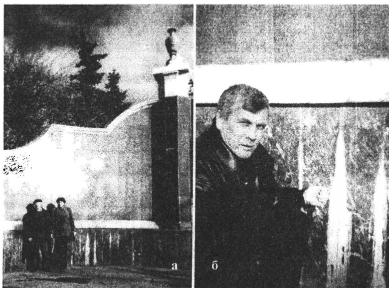
Рис. 3. Натечные коры на стыках облицовки серпентинитовой плиткой главных ворот Центрального ботанического сада в Екатеринбурге: а – общий вид декора ворот, б – фрагмент облицовки с белыми кальцитовыми корами
