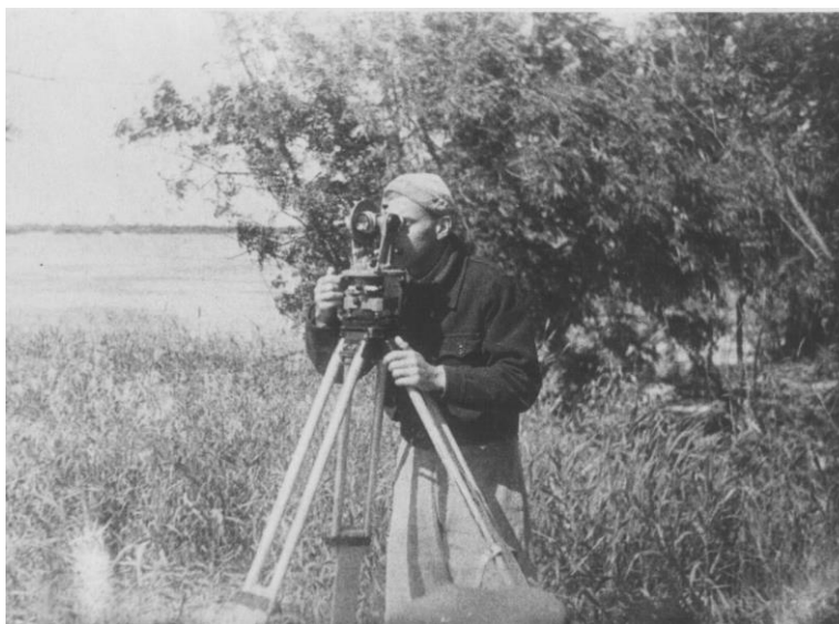
Рис. 6. Съемка магистрали для створов по промерам глубин, 1948 г. Тетеринские перекаты, р. Кама
